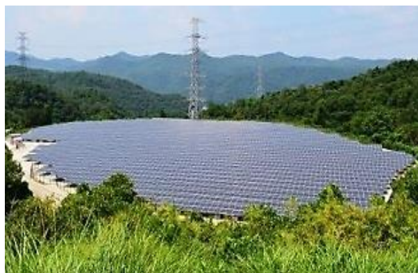
メガソーラー（神戸六甲西太陽光発電所）
