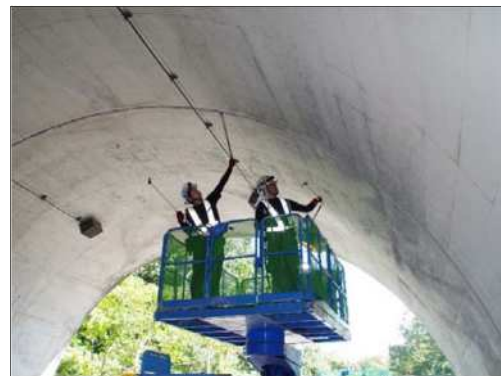
トンネル点検（北区 福地トンネル）
