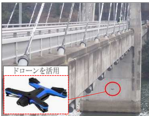
橋梁点検（北区 衝原大橋）
