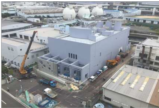
魚崎ポンプ場改築更新事業(第1期) (東灘区)
