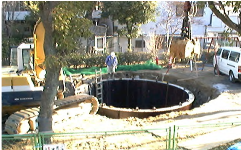
図 公園での耐震性防火水槽の設置
