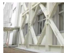
小学校の耐震改修例
