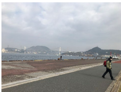
門司港1・2号岸壁
