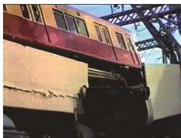
破損した高架橋<東灘>
