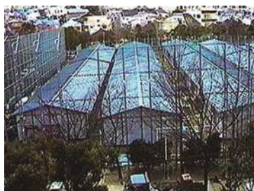
建設が進む仮設住宅
