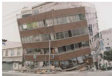
座屈したビル<中央>
