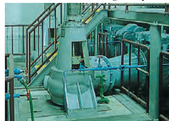
▲汚水ポンプ室
