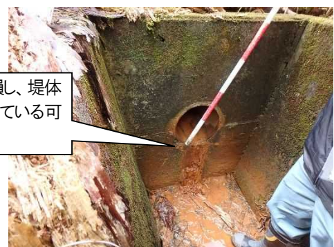
底樋出口(堤体下流)
