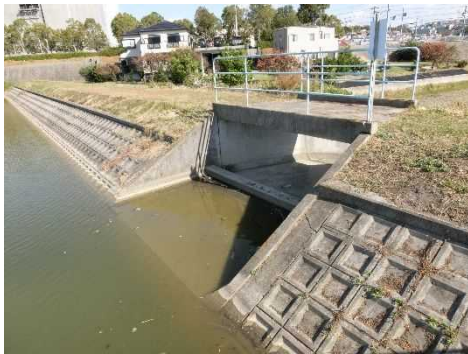
洪水吐(上流側)
