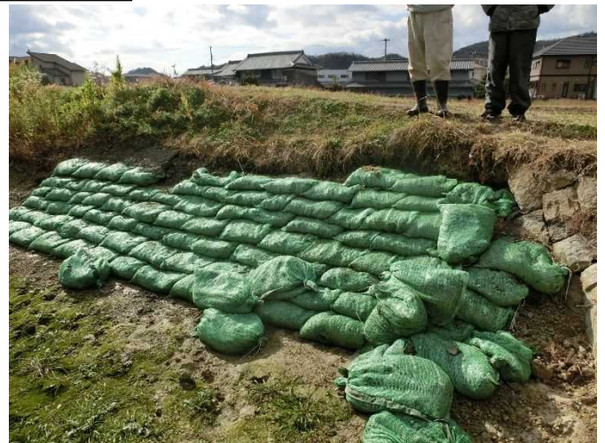
堤体上流法面に土のう設置
