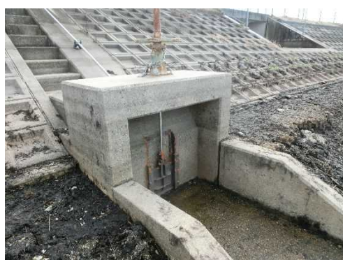
土砂吐ゲート部 腐食及びクラック等の点検
