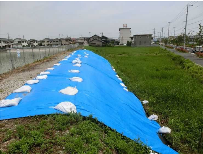
堤体下流法面にブルーシート設置
