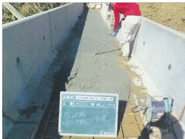
コンクリート打設に先立ち、たまっている水を取り除くとともに、鉄筋についてもどろ等の付着がないように清掃してからコンクリートを打たなければならない。
