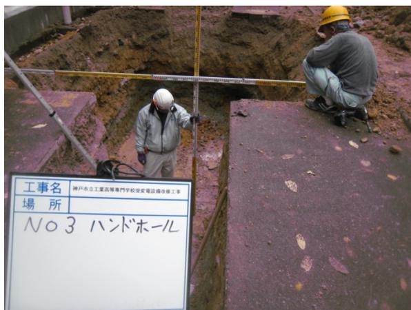
管路掘削において、土留めが施工されていない
