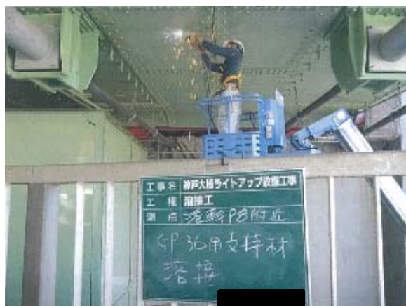
(みなと総局技術部工務課) [No.56 神戸大橋ライトアップ設備工事] (請負金額 109,536 千円)
