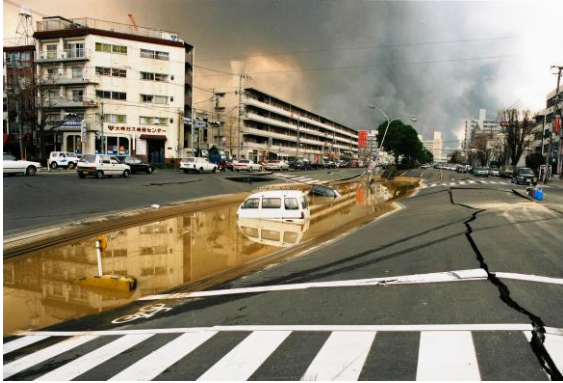
陥没した道路。市内のいたる所に地割れがおこり、交通渋滞がおきました ＜神戸新聞社提供＞
