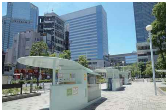
○需要に応じた規模と景観への配慮を兼ねた駐輪場の整備。（東京都港区：地下機械式駐輪場）
