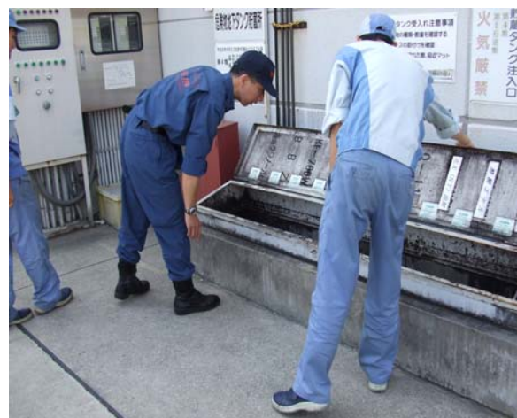
地下タンク貯蔵所の立入検査
