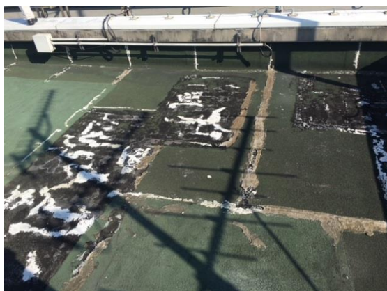
施設の老朽化例（屋上防水や外壁の劣化）
