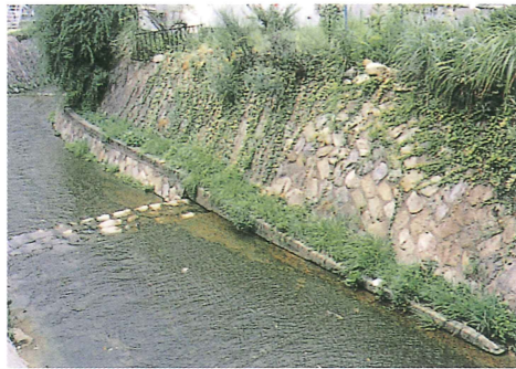
石屋川の水車用水路跡 石垣に沿ってある側溝で水を水車まで引いた。
