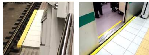
スロープ・櫛ゴム設置による段差及び隙間縮小
