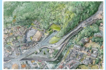
トンネル東側
