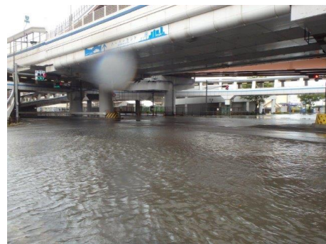
写真 台風襲来による道路冠水被害 (神戸市中央区・国道2号、平成30年9月)
