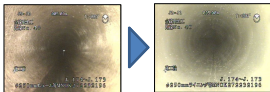
施工前 施工後 写真 管更生工事前後の管きよ内部
