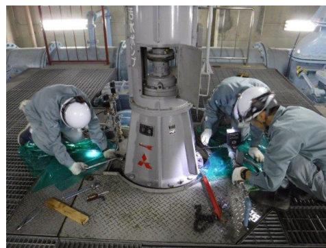
写真 設備の補修・修繕作業
