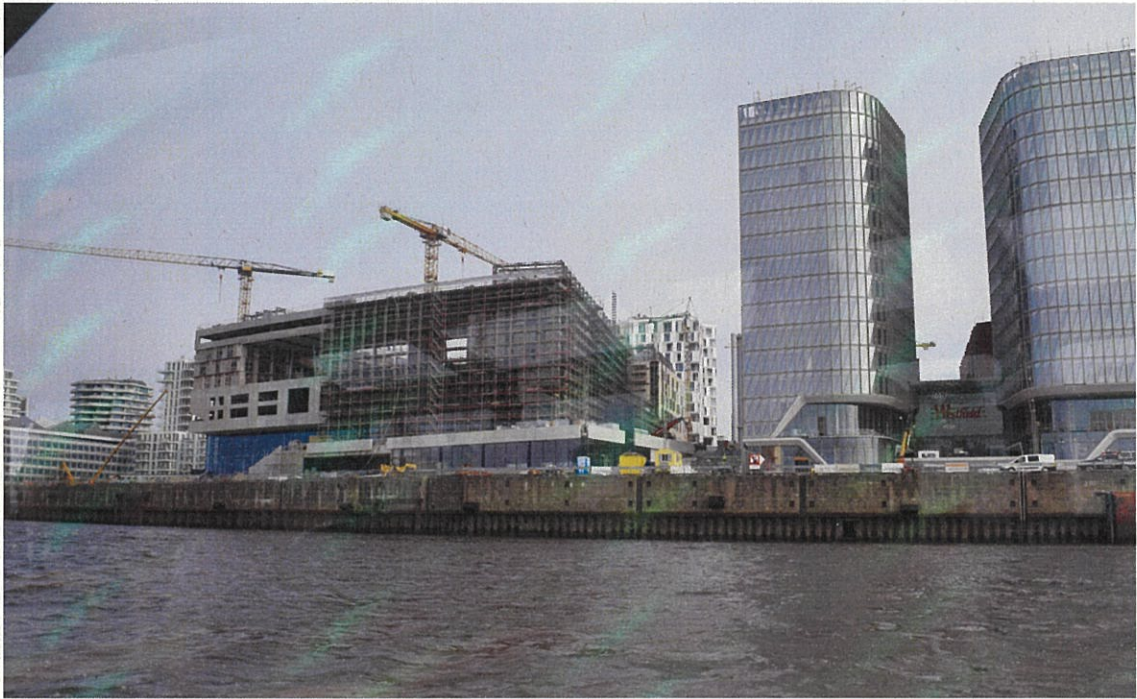
ハーフェンシティで建設中のクルーズセンター
